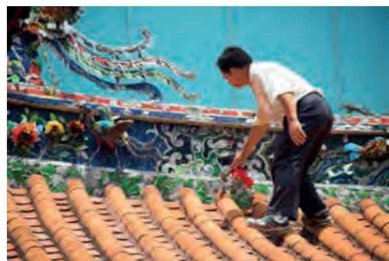
民國 104 年後殿屋頂動工
