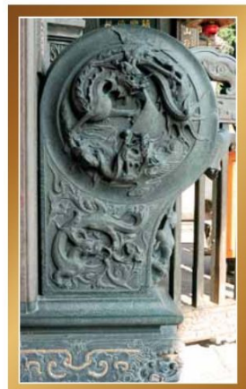
▲石鼓依其外形可分為上、中、下三段，上段為突出的圓形鼓面，中段為托住鼓面的梯形或矩形鼓架，下段是承托整個石鼓的基座。左邊向內面石鼓，雕大小二龍，大龍在上吐水施雲降雨，下方小龍仰視以承之，有「蒼龍教子」之意。
