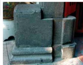
▶西園路側門門枕石近照，放置門樞的凹型石槽，以及安裝門軸的門臼清楚可見。此照亦可看出門枕石並非一獨立的構造。
